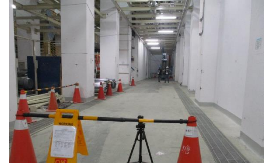
高架作業基本配備：監視人員、DV、 警示圍籬
